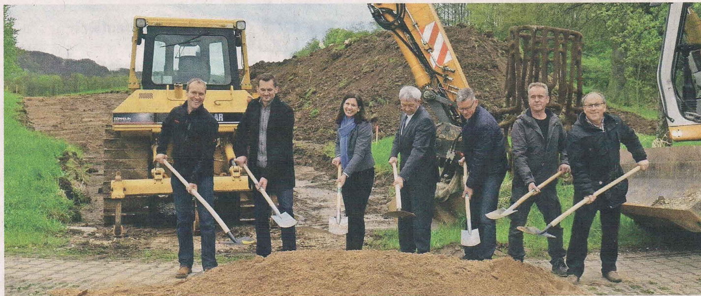
Die Offiziellen packen beim Spatenstich gemeinsam mit an.
