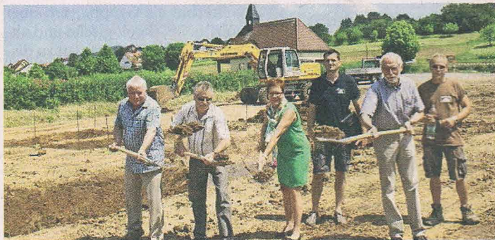
Bürgermeisterin Anja Gebhardt (M.) beim Spatenstich
